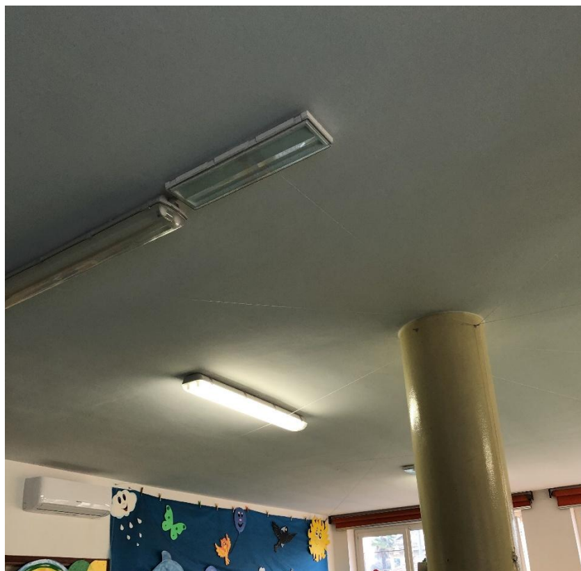
Figura 3 - Plafoniera neon a fluorescenza con 2 tubi da 1,20 m nell'area giochi e pranzo 1
