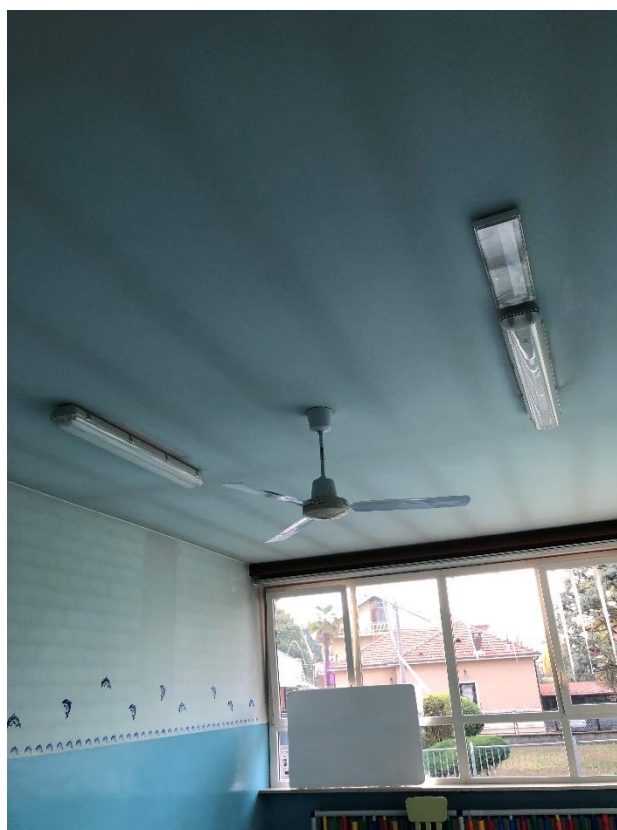
Figura 4 - Plafoniera neon a fluorescenza con 2 tubi da 1,20 m nella stanza psicomotricità 1
