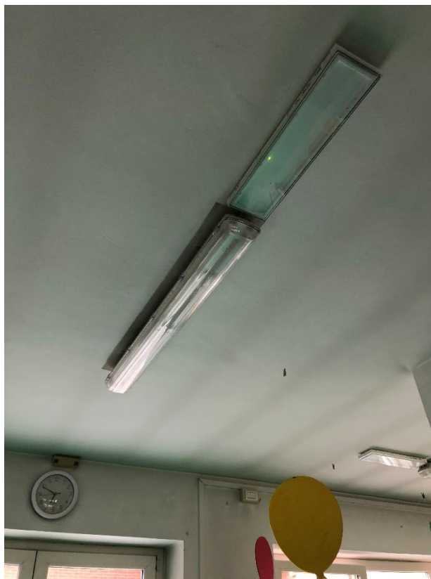
Figura 1 - Plafoniera neon a fluorescenza con 2 tubo da 1,20 m nel corridoio 2
